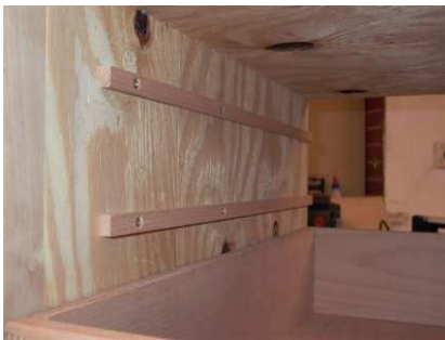
Die Führungsleisten wurden mit je 3 Schrauben befestigt.
